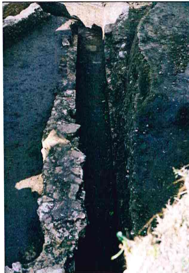
Figura 11 – Uno dei canali di scolo scavati, privo di copertura
