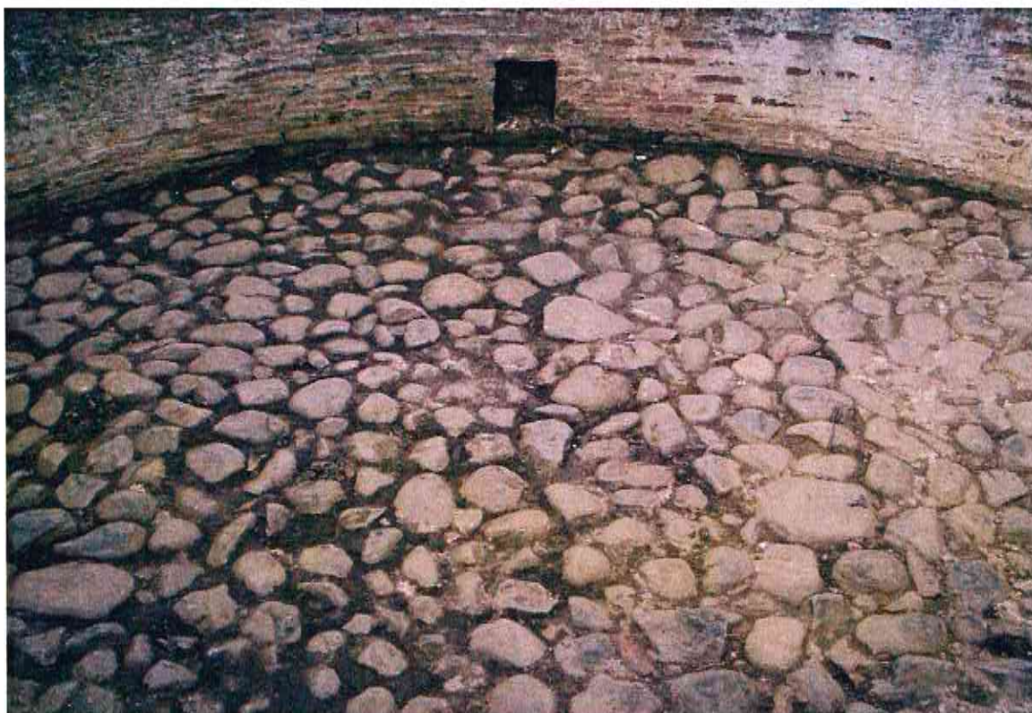
Figura 10 – Il vespaio in ciottoli di fiume dell'abside ovest del frigidarium
