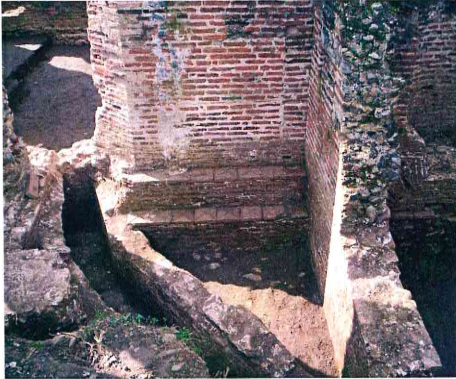
Figura 8 – I bessali costituiscono i piani di risega delle fondazioni dei muri in opus testaceum
