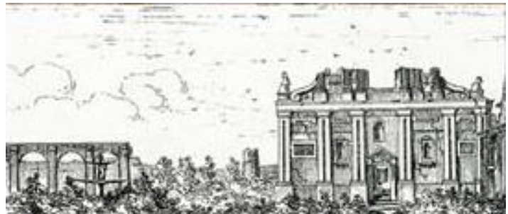
Fig. 5 Rovine del Chiostro con facciata della Chiesa cinquecentesca
